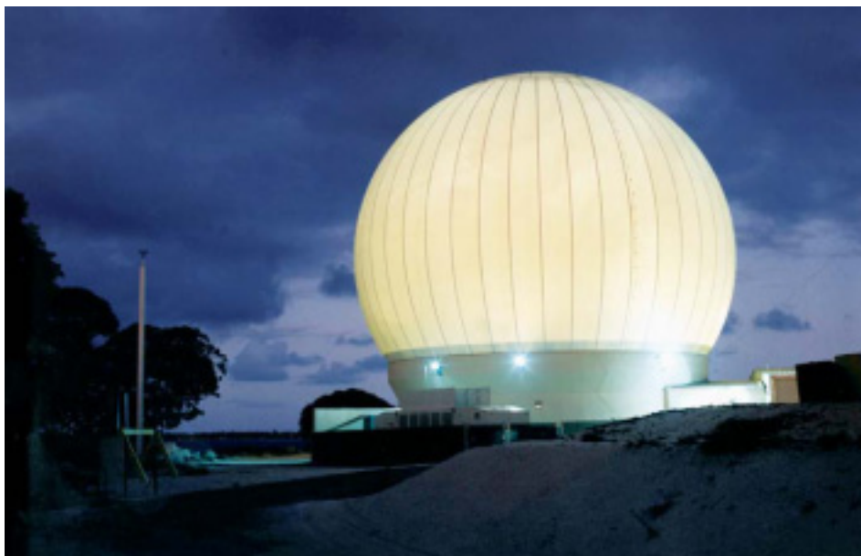
РЛС типа GBR (XBR) для обнаружения пусков ракет и сопровождения их в полёте, установленная на атолле Кваджелейн
