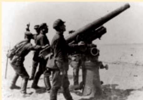
Легкое артиллерийское орудие обр. 1900 г. на специальной установке для стрельбы по воздушным целям.
